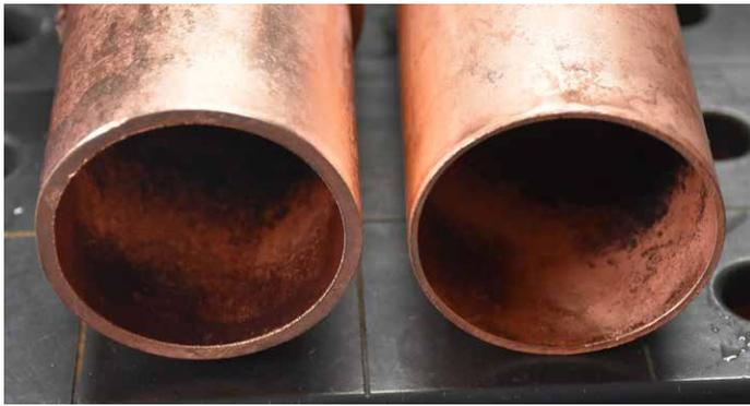
**Bild 13:** Beispielsweise für Kälteanlagen mit R744 (CO<sub>2</sub> als Kältemittel) wird das dickwandigere und höherfeste Kupferrohr aus K65 (links) verwendet – rechts im Vergleich das normale Kupferrohr desselben Nenndurchmessers, also 54 mm. (© VauQuadrat GmbH)
